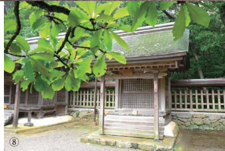
⑤_ 高宮祭場(たかみやさいじょう) 宗像三女神が降臨したと伝えられる場所。この日は雨で霧が立ち込めていました。⑥⑦_ 現在の本殿・拜殿は天正年間に再建されたもので、国の重要文化財に指定されています。⑧_ 境内には多くの末社があり、信仰の篤さが伺えます。第3代福岡藩主・黒田光之の時代の社も見られます。⑨_ 第二宮・第三宮(ていにぐう・ていさんぐう) 沖津宮、中津宮のご分霊を祀っており、ここへ詣りすれば大島・沖ノ島へ行かずに宗像三宮を参拝することになります。社殿は伊勢神宮から特別に下賜された古宮を移築再建しました。
